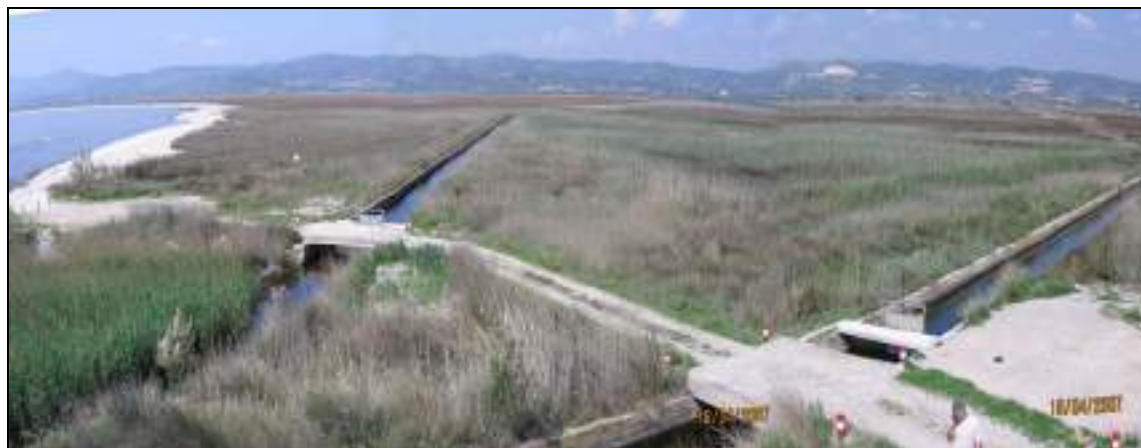
Imagen 6. Canales de drenaje en la Gola del Trenc. Se aprecian las compuertas instaladas para evitar la entrada de agua del mar al interior del Prat.
